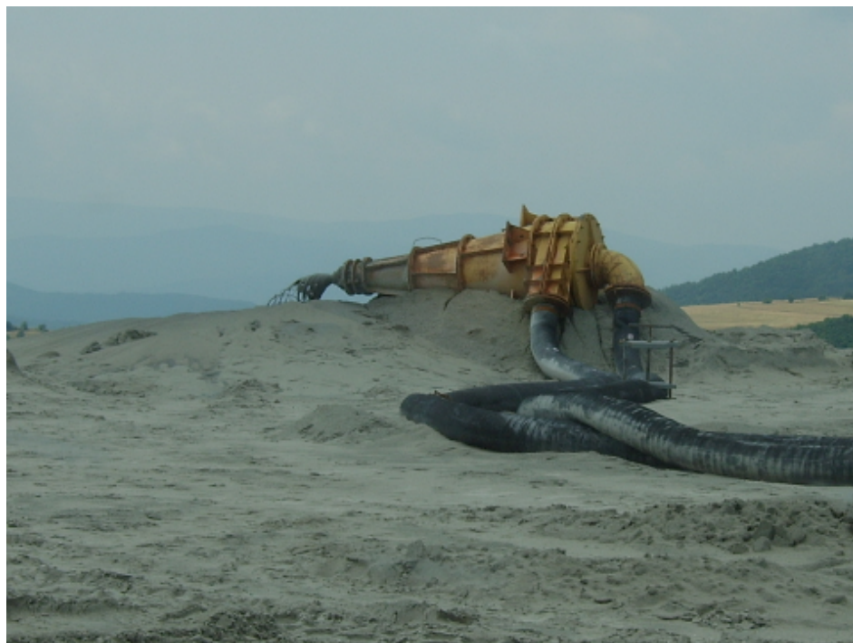
Фиг.3. Изграждане на хвостохранилище с хидроциклониран хвост
