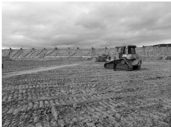
Фигура 7. Заравняване на обработената площ с булдозер Caterpillar C6N (ляво) и валиране с валик AtlasCopco CA2800 (дясно) (по Munro, 2017)
