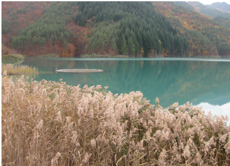
Фиг.2. Хвостохранилище „Ерма река“ - утаечно езеро с преливна шахта за избистрени води
