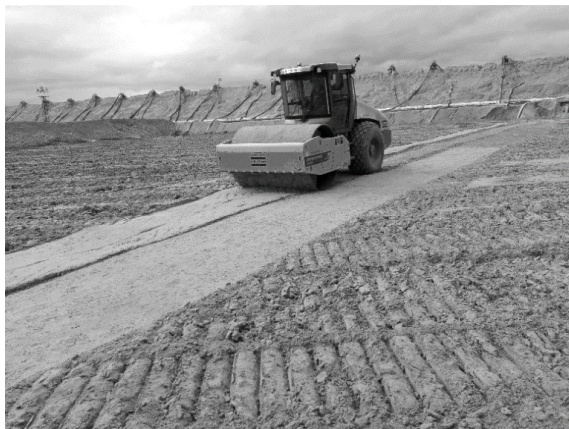
Фигура 7. Заравняване на обработената площ с булдозер Caterpillar C6N (ляво) и валиране с валик AtlasCopco CA2800 (дясно) (по Munro, 2017)
