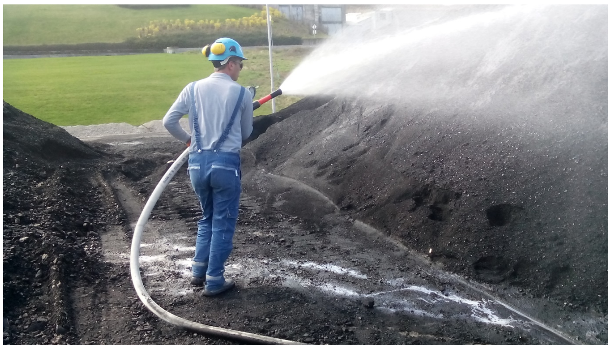
Фиг.1. Нанасяне на разтвора на биндера от водоноска с помпа чрез пожарникарски маркуч със струйник
