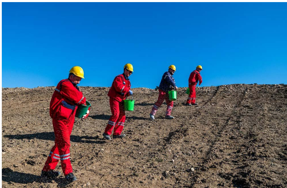
Фиг.9 – Полагане на тревна смеска върху рекултивиран откос
