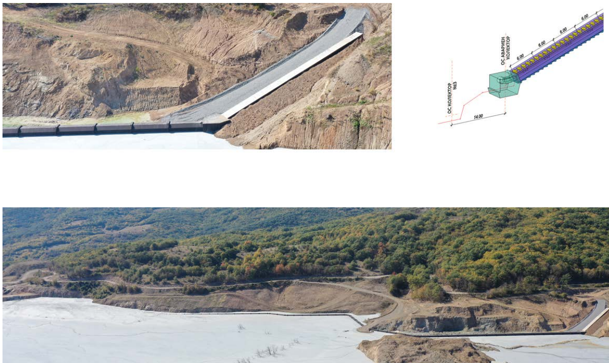
Фигура 15 – Аварийен стоманобетонов преливник и колектор Ø1400
