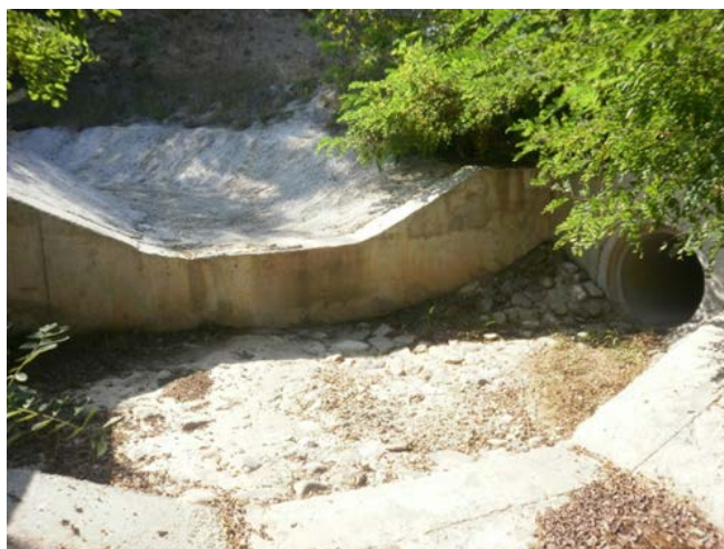
Фиг. 5. Отвеждащо съоръжение
