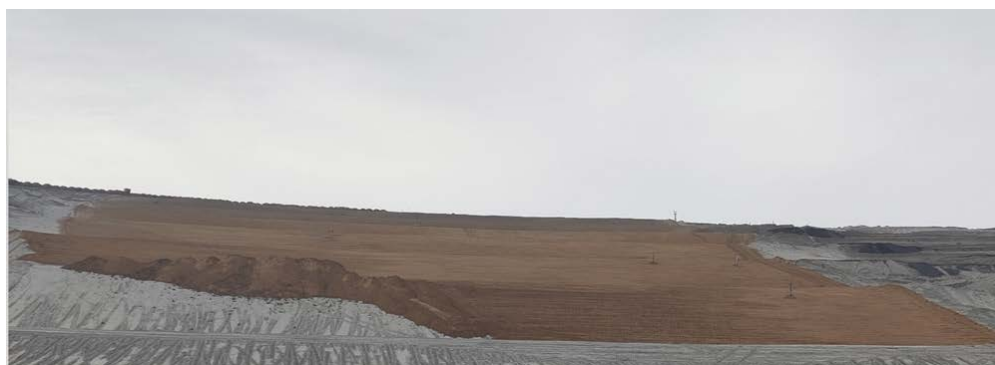
Фиг. 14. Техническа рекултивация на части от въздушен откос, секция „Ай дере“
