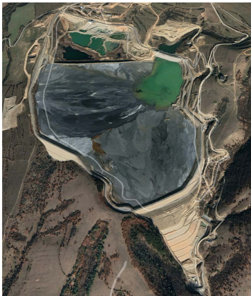
Хвостохранилище Челопеч по време на строителство на затежняващия насип
