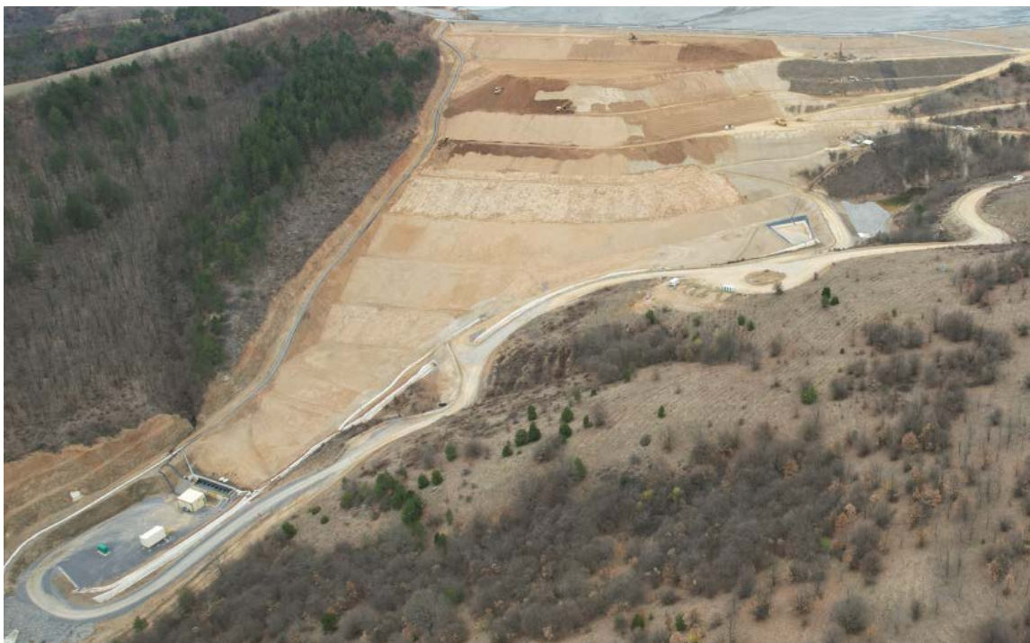
Ситуация (по време на строителство) на затежняващия насип на Основна (Южна) стена на хвостохранилище Челопеч
