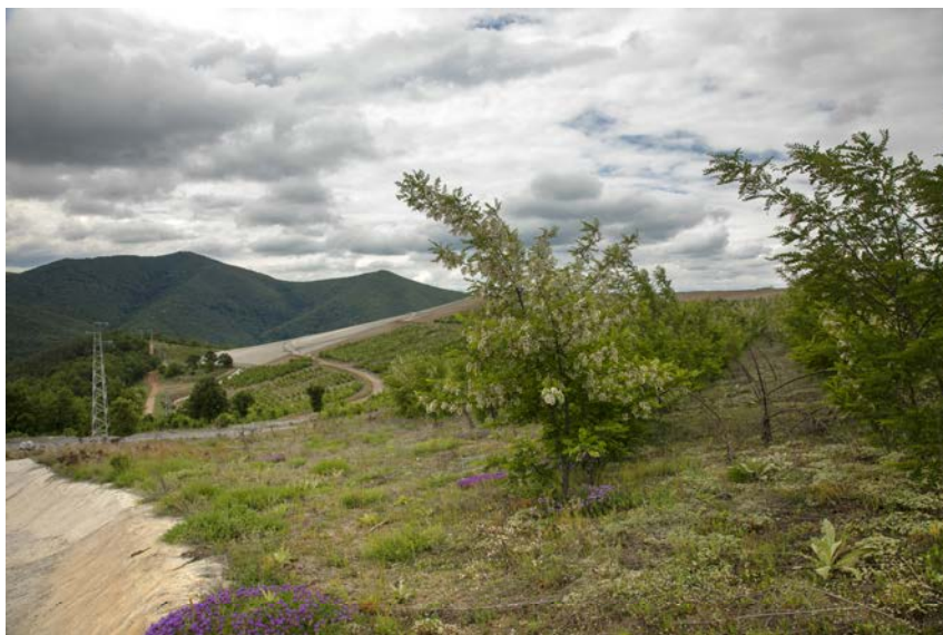
Фиг. 11. Техническа и биологична рекултивация на площи от въздушния откос на хвостохранилище „Бенковски-2“.
