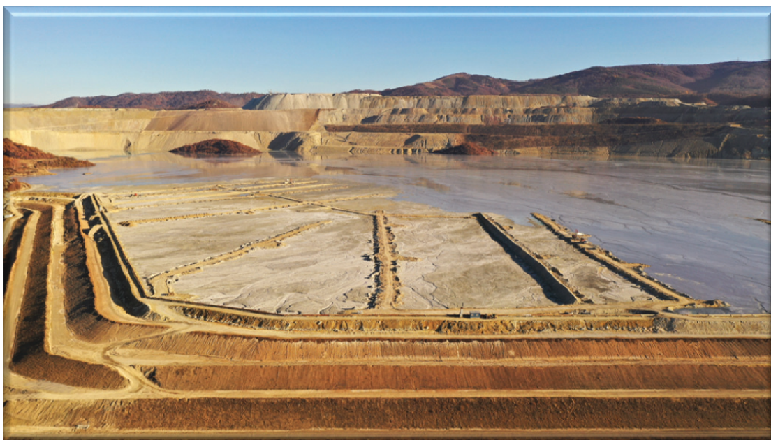
Фиг. 4 Допълнителни мероприятия за намаляване на порово налягане и ускоряване процесите на консолидация.
