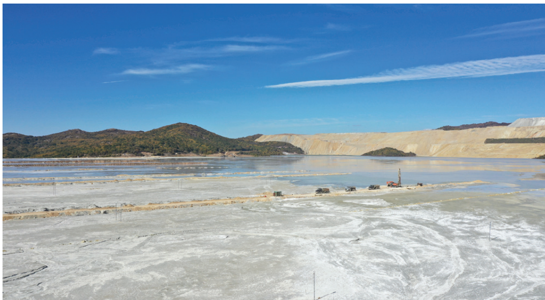
Фиг. 4 Пиезометри в плажа на хвостохранилище „Люляковица“, 2024 г.
